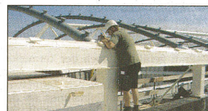
Bauarbeiten auf dem „Adidas“-Firmengelände in Herzogenaurach.
