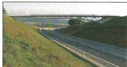
Architektonisches Schmuckstück: Die Köstener Autobahnbrücke.
