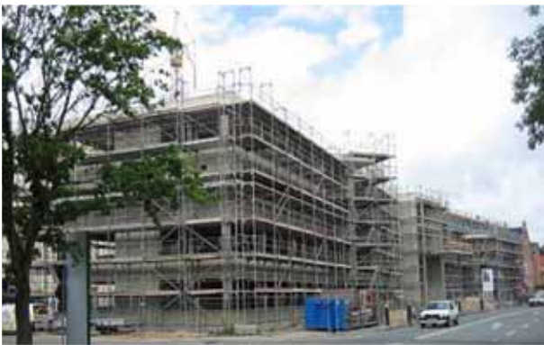
Verwaltungsgebäude im Rohbau
