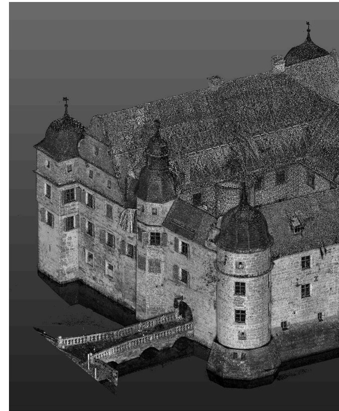
Punktwolke des Wasserschlosses von außen
